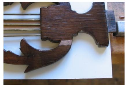
Einsetzen der fehlenden Holzteile auf Vorder und Rückseite.
