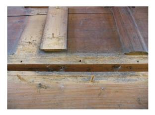
Alle losen Teile wurden zerlegt und gereinigt, dabei wurde darauf geachtet die alten Holznägel nicht zu beschädigen so dass alle Teile beim verleimen wieder exakt positioniert wurden.
